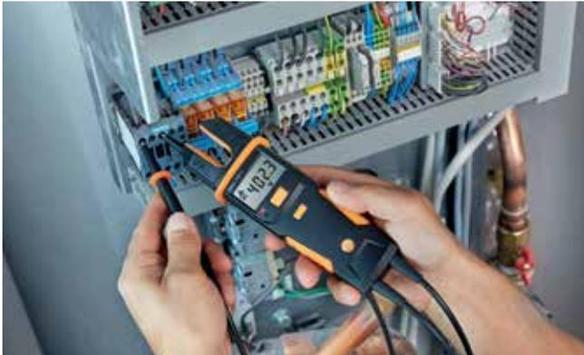
Control de tensión en una bomba de calor con **testo 755**.
