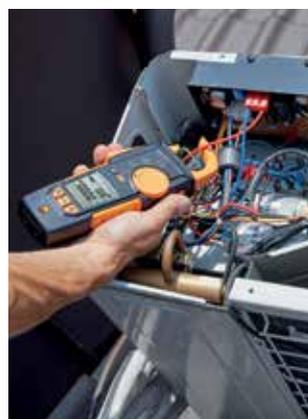
Enhebrar las pinzas amperimétricas a una unidad exterior de frío.
