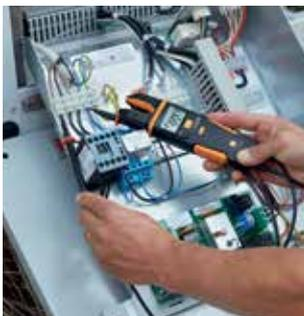
Medición de tensión en un compresor.
