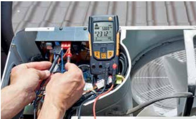
Medición de tensión en una unidad exterior de frío con **testo 760**.
