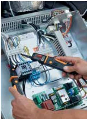
Medición de tensión en un compresor.
