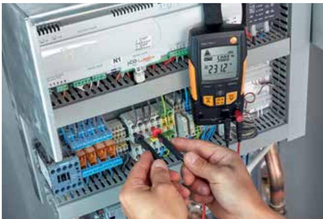
Control de tensión en el panel de conexiones de una bomba de calor.
